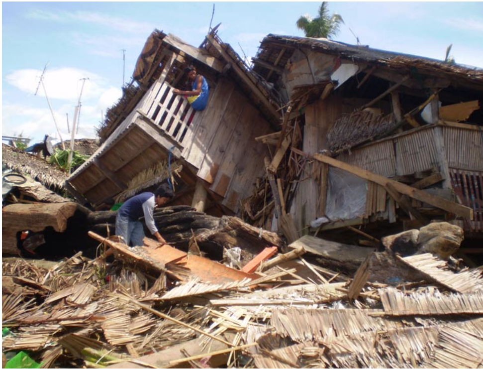
Schäden nach einem Taifun in den Philippinen
